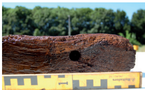
Afb. 6.19 detail van het boorgat.
